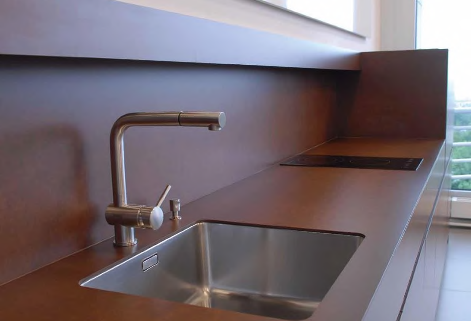
Фото 21: Ограждение от разбрызгивания жидкости, горизонтальные и вертикальные поверхности без стыков с HPL
